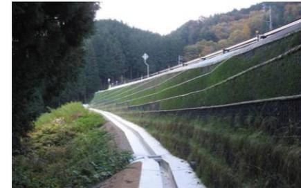
調査の対象とした補強土壁工法
